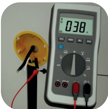
12 kontrola měření odporu topného okruhu
