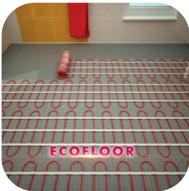
10 rozvinutí a zafixování topných rohoží Fenix pomocí opravné hmoty weber.bat opravná hmota
